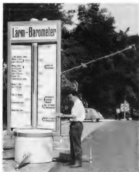
Über 3,5 Meter hoch ist dieses Riesen-Phonmeter, das die Firma Honegger Elektronik anlässlich der Lärmbekämpfungswochen für die Stadt Zürich gebaut hat. Es zeigt den Schalldruck von 40 bis 100 dB (gleich DIN-Phon), nachts sind die Plexiglas-Skalen von innen beleuchtet. Eine volltransistorisierte „Elektronik“ steuert ein rotes Nylonband als Anzeigegläser in einem Plexiglasrohr
